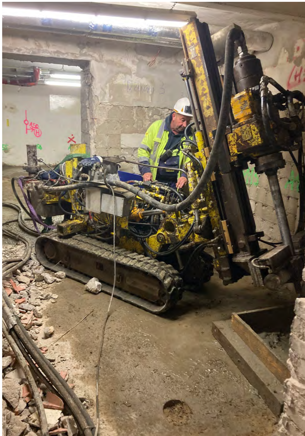
Arbeiten unter beengten Platzverhältnissen im Keller der Klinik.
