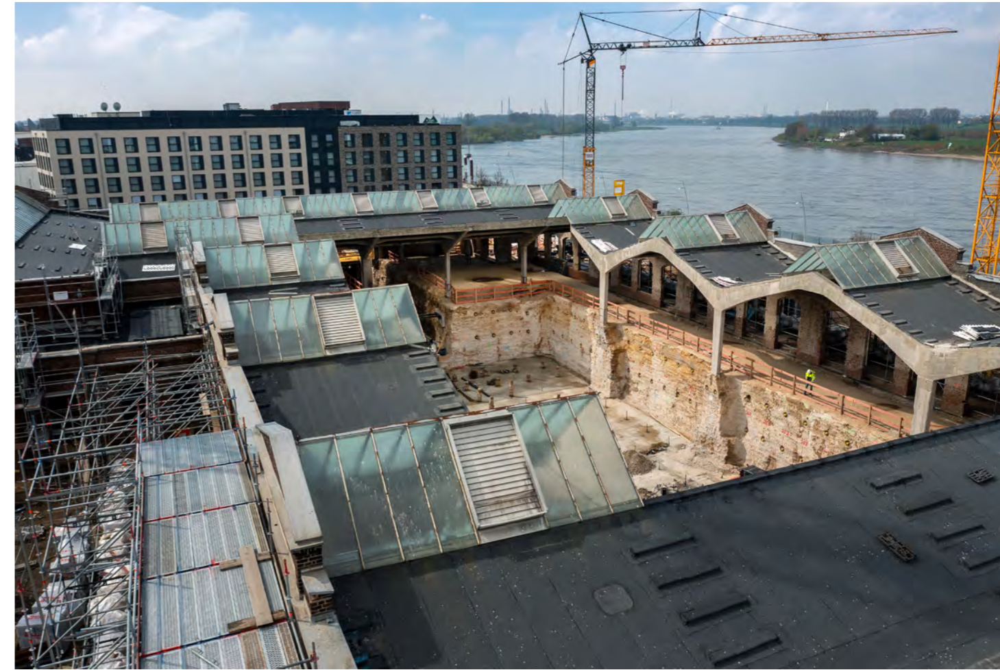
Die Baugrube befindet sich inmitten der historischen Abfüllhallen.
