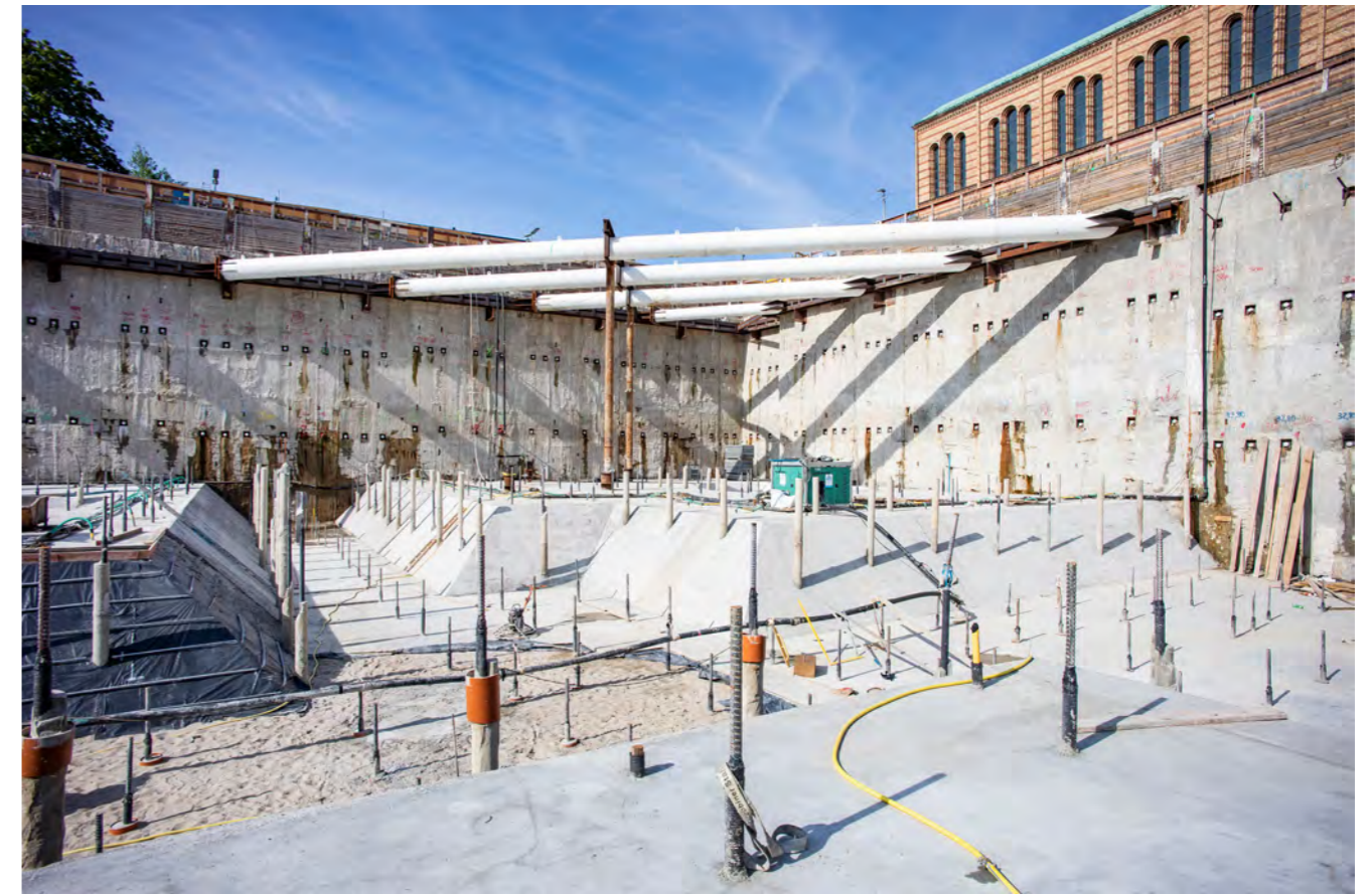
Die DSV-Dichtsohle ist über rund 1.000 Mikropfähle gegen Auftrieb rückverankert.
