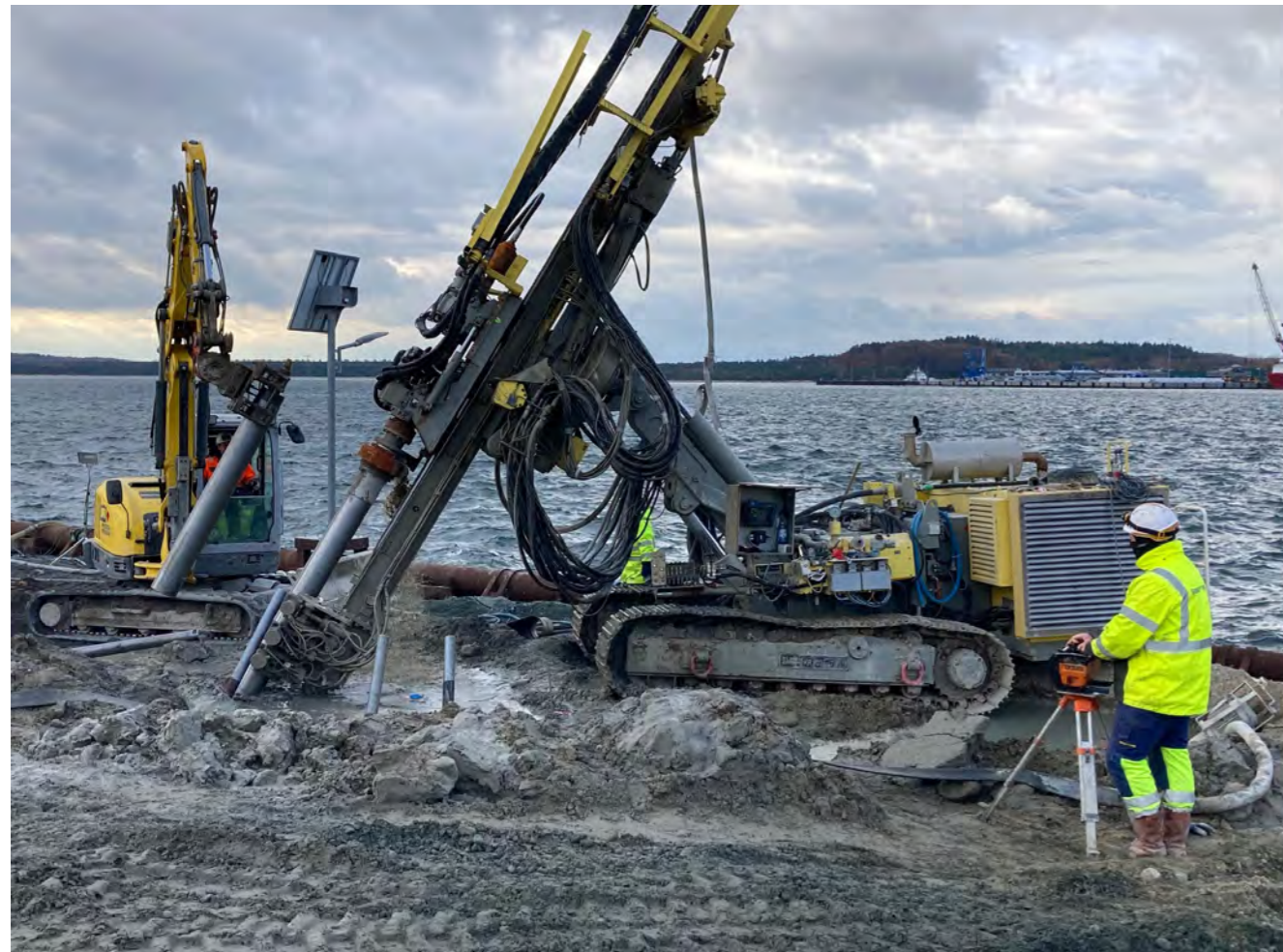
Abbohren bis auf Oberkante DSV-Körper
