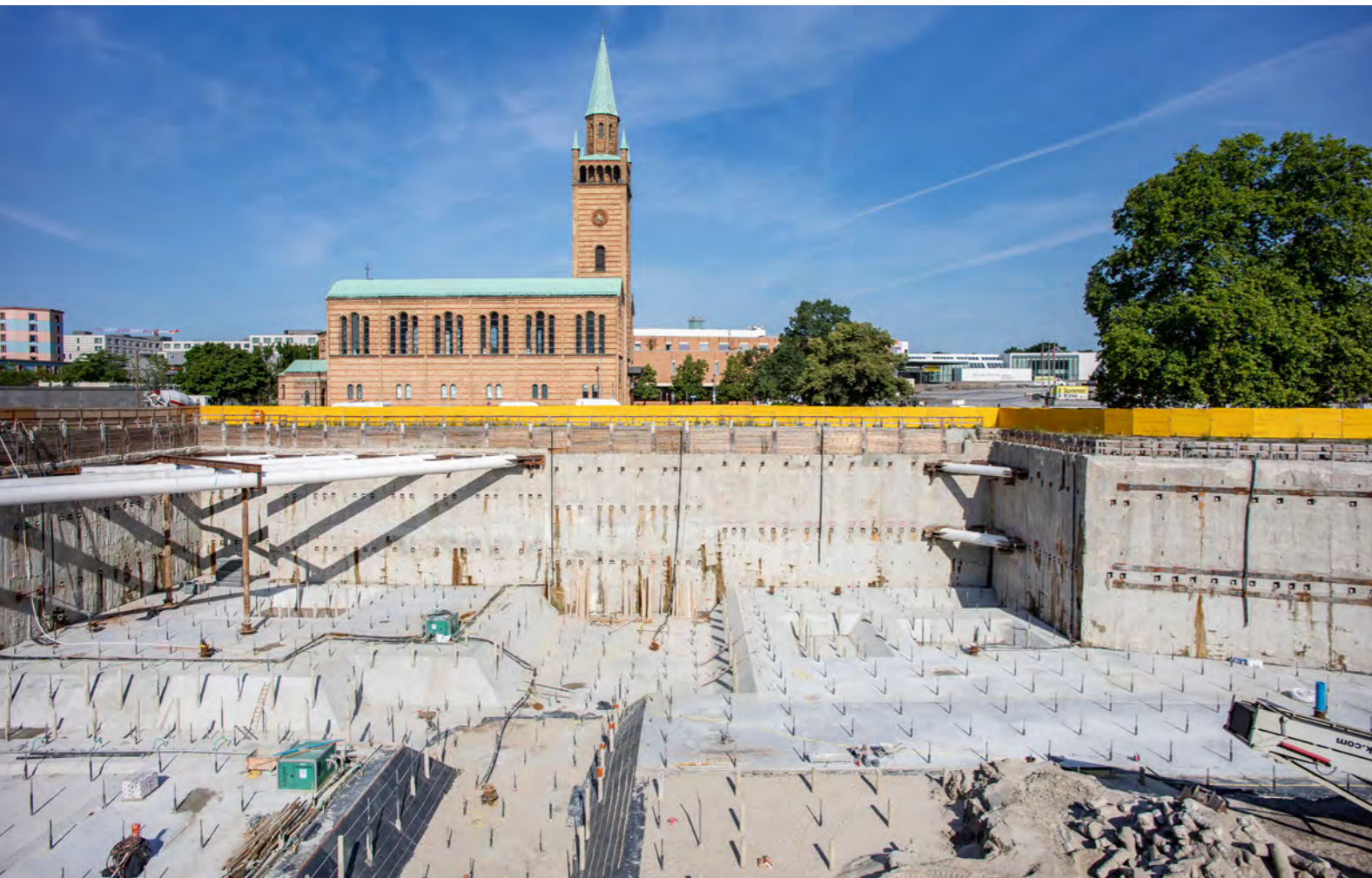
Blick in die fertige Baugrube mit angrenzender St. Matthäus-Kirche.
