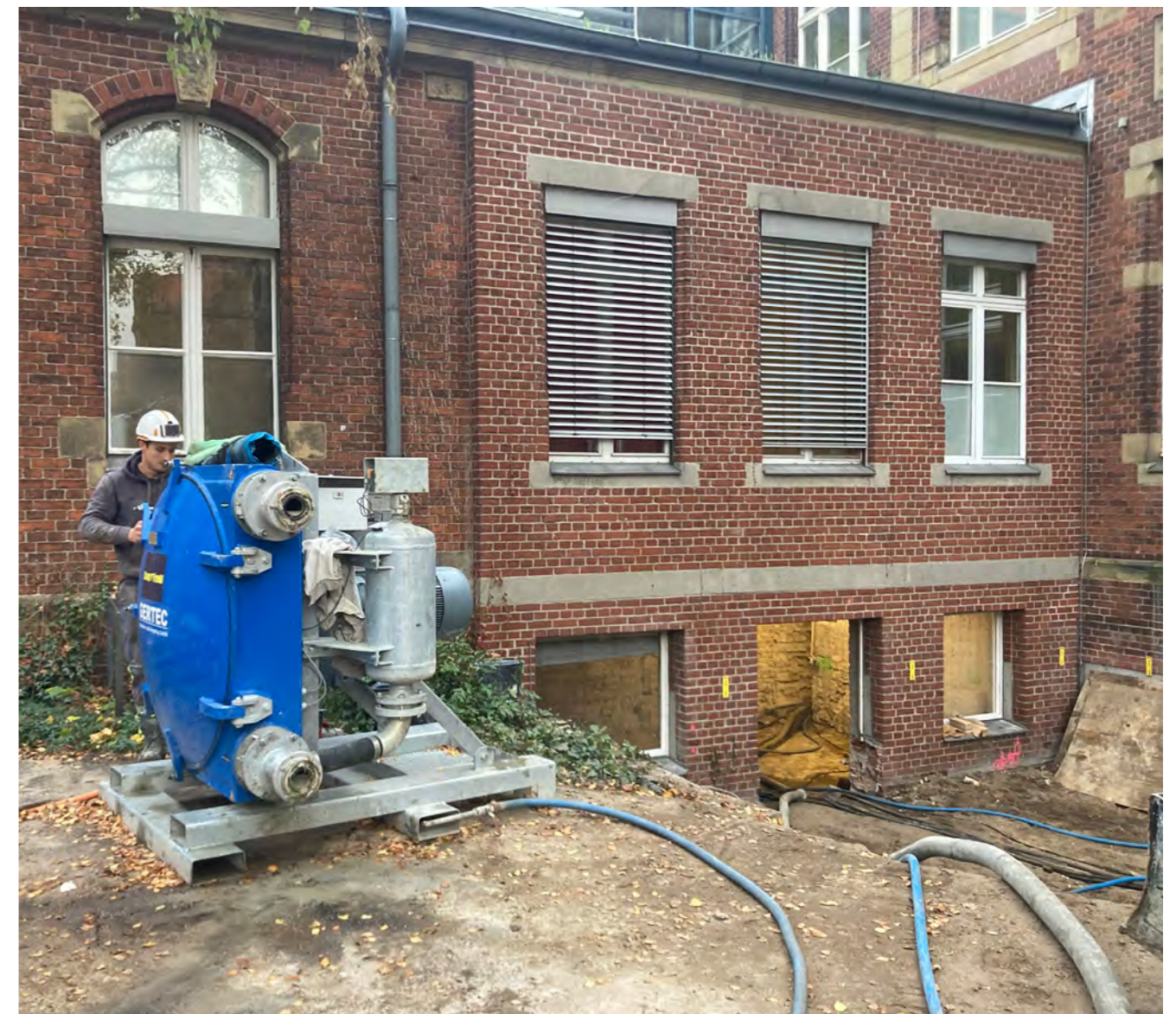
Die Unterfangungen mussten während des laufenden Klinik- und Kreißsaalbetriebs durchgeführt werden.
