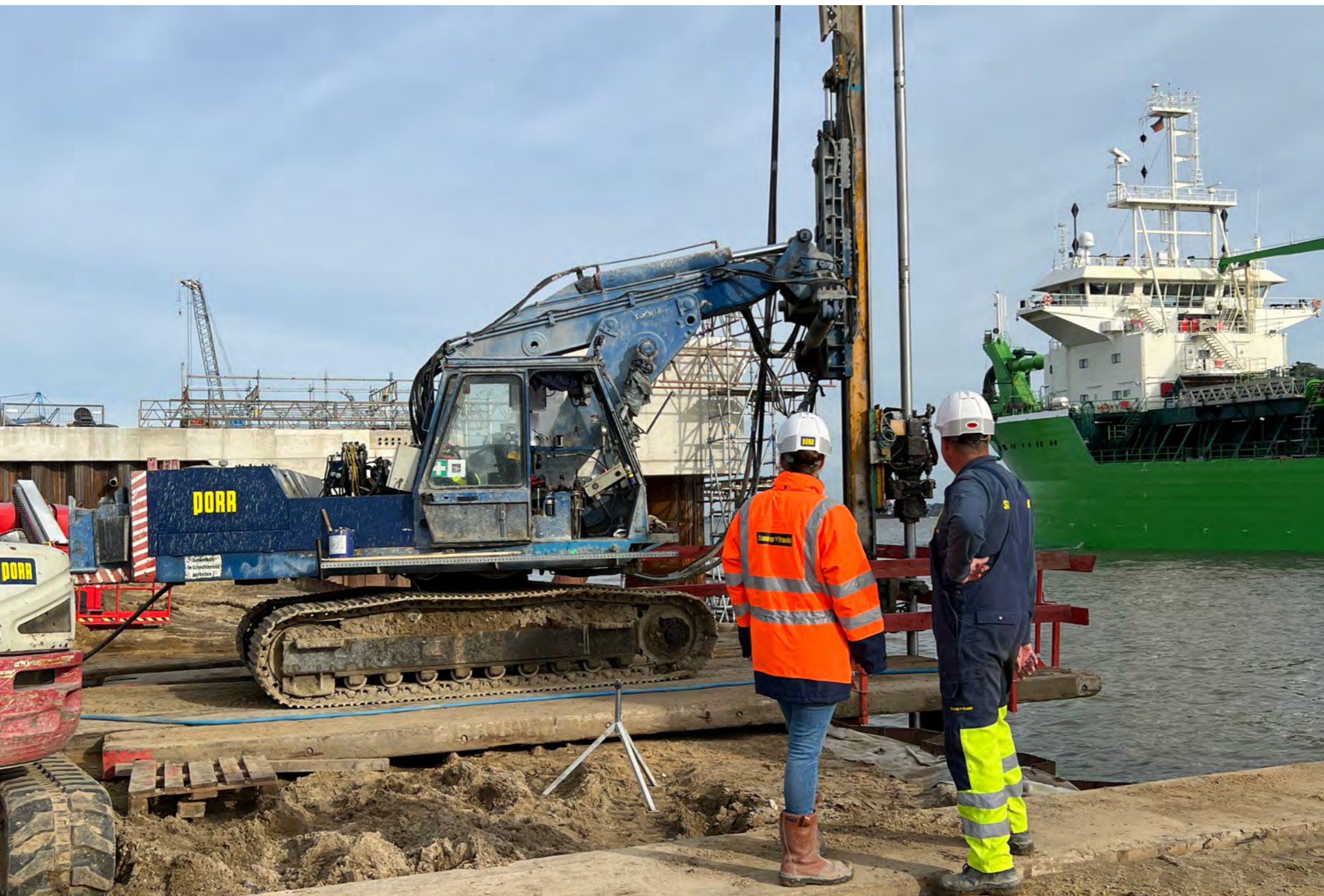
Die dichtenden DSV-Säulen werden unterhalb der Spundwand erstellt.
