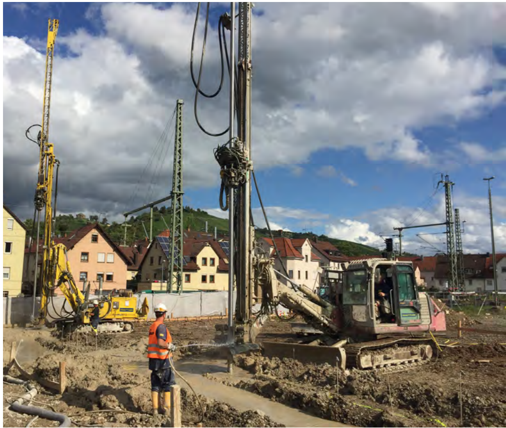
Ausführung der DSV-Abdichtung mit zwei Bohrgeräten
