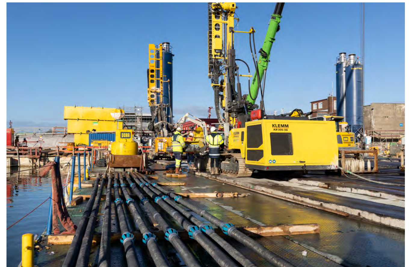
Beim Bau der 5. Schleusenammer in Brunsbüttel wurden Düsenstrahlpfähle von PORR Spezialtiefbau sicher ausgeführt.
