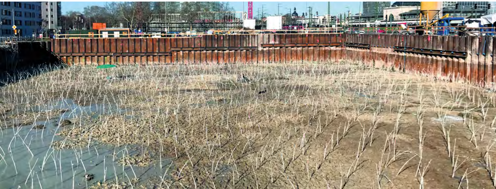
Weichgel-Injektionssohle als Dichtsohle mit geringem CO 2 -Footprint
