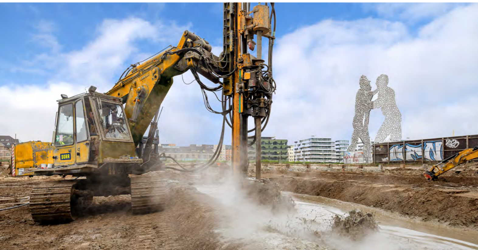
Bohrgerät für Düsenstrahlsohle in Berlin
