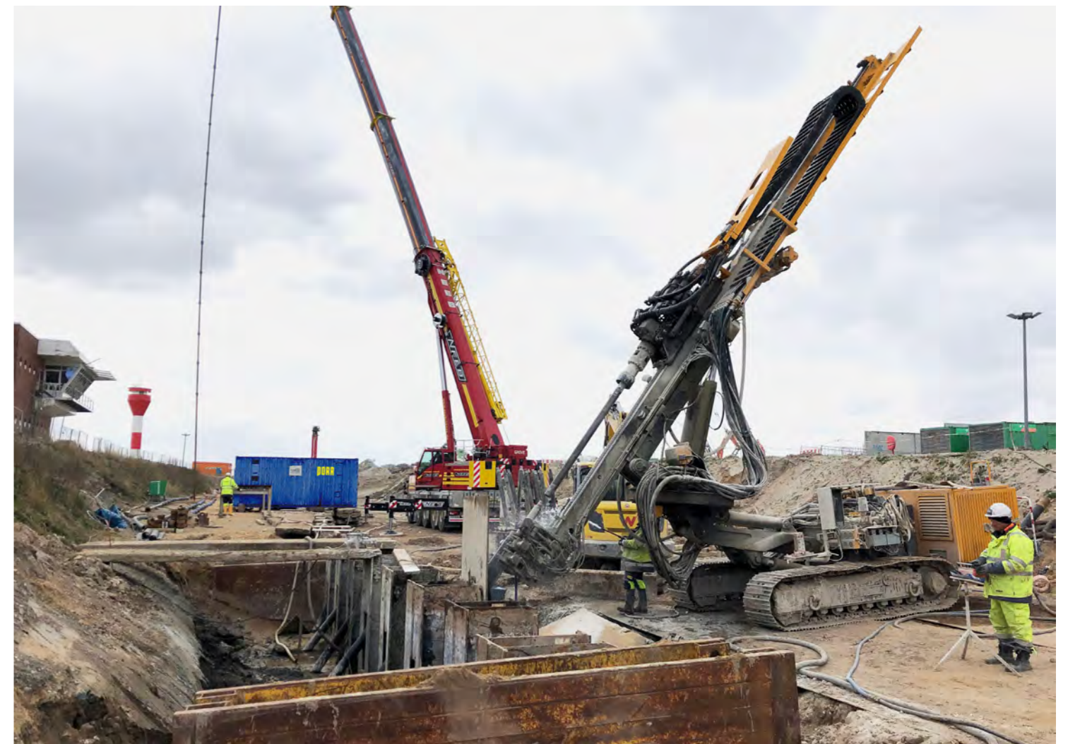
Herstellung von Düsenstrahlpfählen an der Schleuse Brunsbüttel
