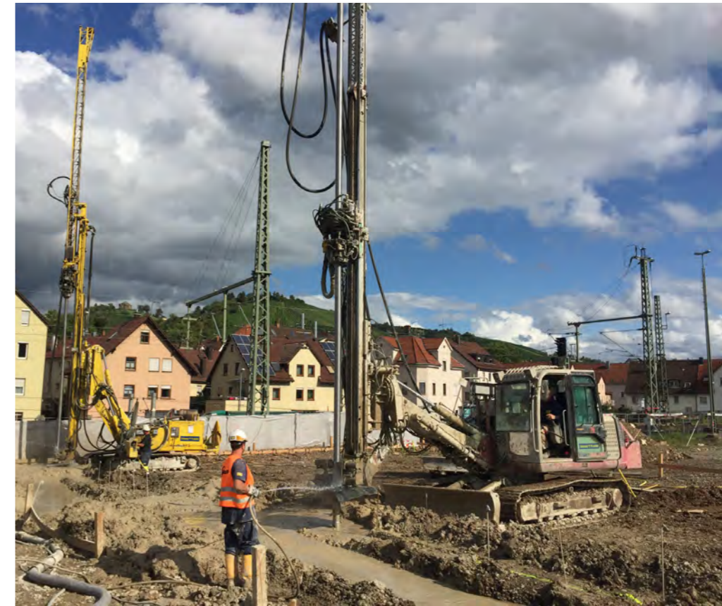
Ausführung der DSV-Abdichtung mit zwei Bohrgeräten
