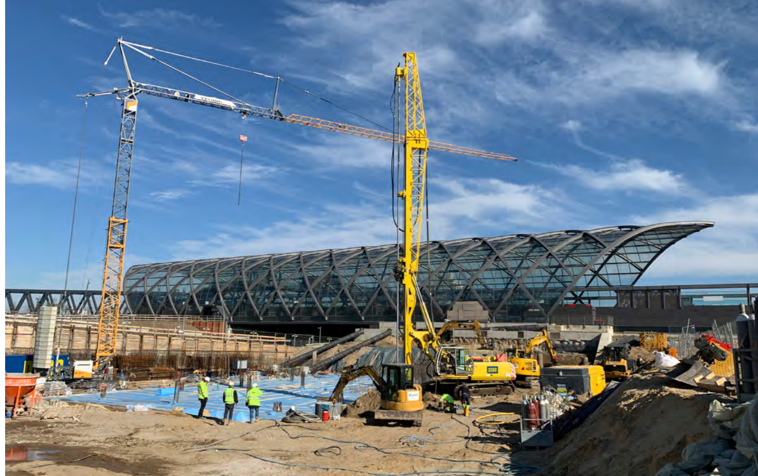
Düsenstrahlarbeiten in der Hamburger HafenCity
