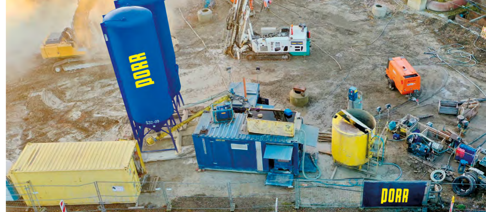
Baustelleneinrichtung für das Düsenstrahlverfahren
