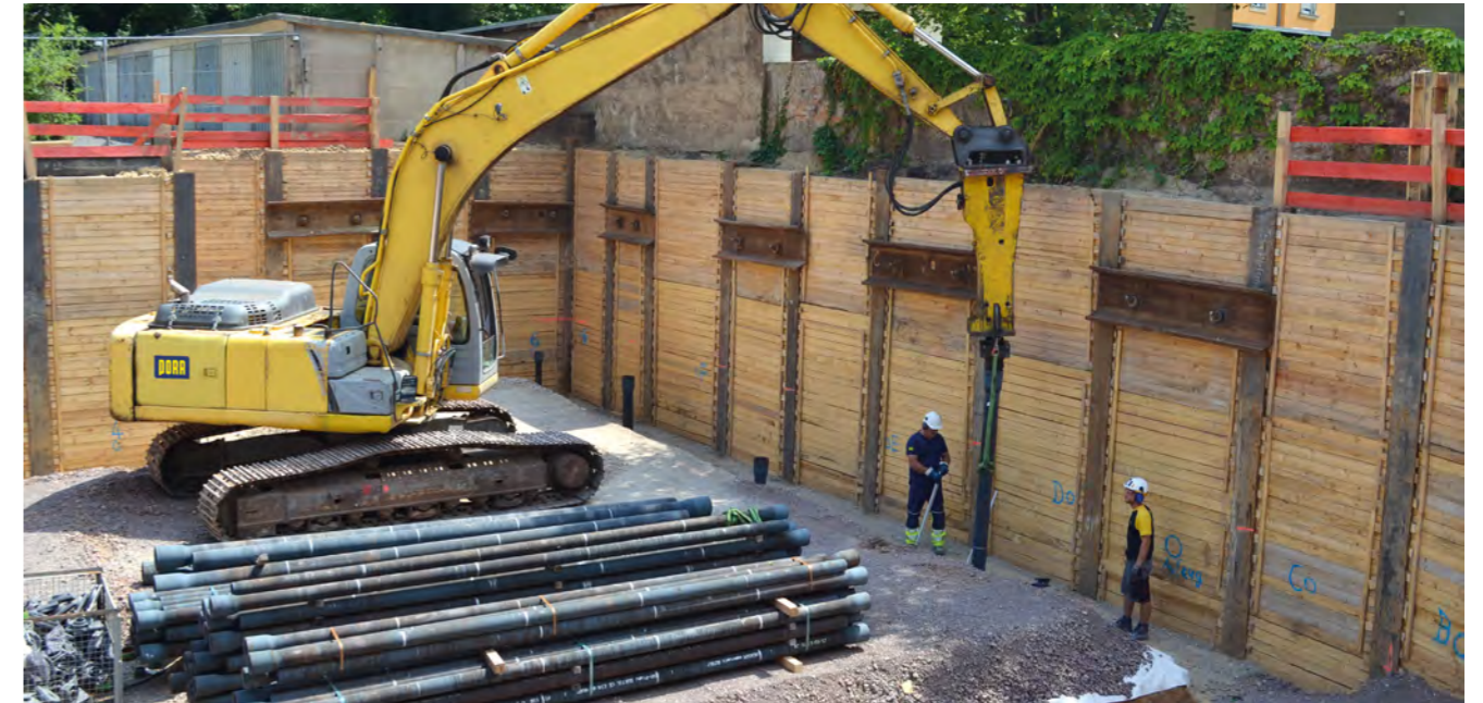
Einrammen von HLV-Pfählen
