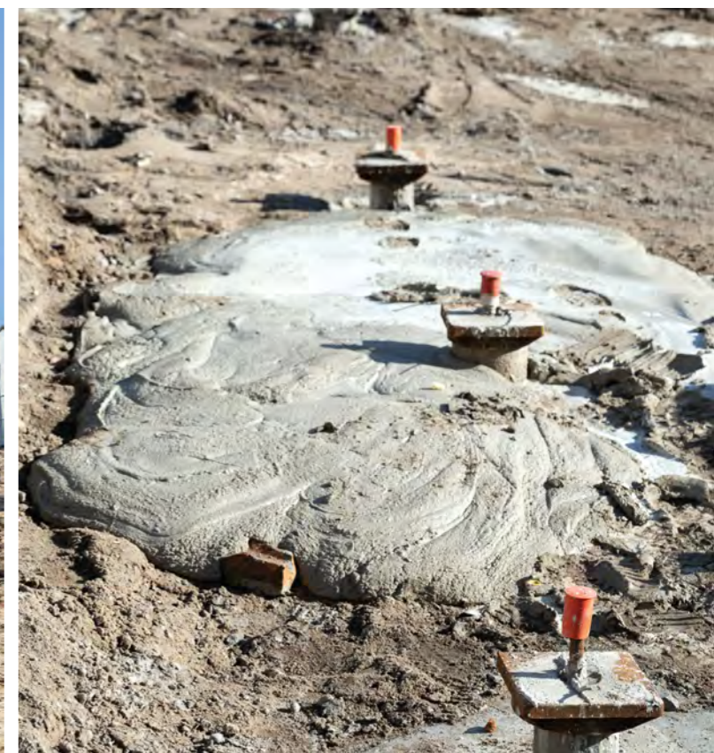
Der Pfahlkopf wird mit einer Druckverteilungsplatte ausgebildet.
