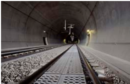
Feste Fahrbahn, Deutschland
