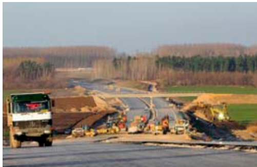
Autobahn M6, Ungarn
